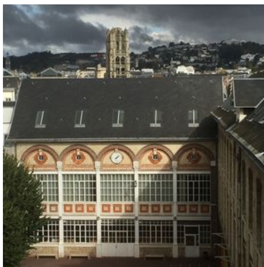
Le bâtiment C où sont installés, au rez-de-chaussée, le restaurant scolaire, au 1er étage, le CDI et au 2ème, le gymnase.
