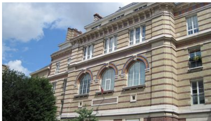
Le bâtiment A qui abrite l'administration de l'établissement et l'amphithéâtre.
