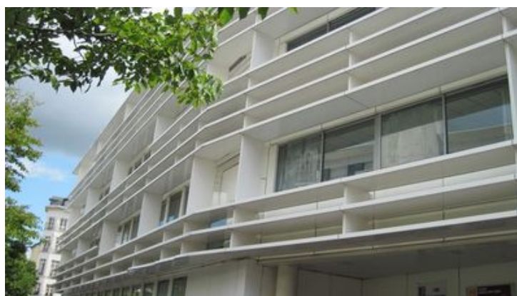
Les bâtiments D et E sièges des laboratoires de sciences, de technologie et d'arts plastiques, ainsi que des salles d'enseignement général du lycée.
